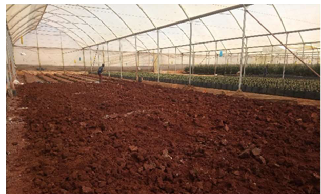
上:ウッドチップパーのデモの様子、下:人力で耕運したハウス内の様子 デモンストレーション実施の様子
